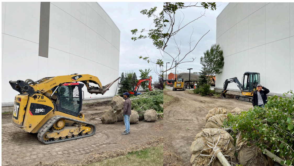
Xây dựng Đài Đức Mẹ La Vang
